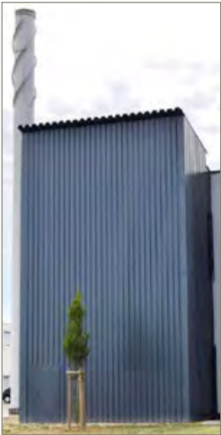
Abb. 34: Beispiel eines eingehausten Pelletsilos zur Außenaufstellung
