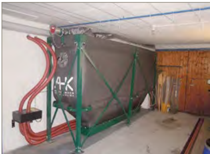
Abb. 10b: Trog silo mit mehreren Saugentnahmepunkten
